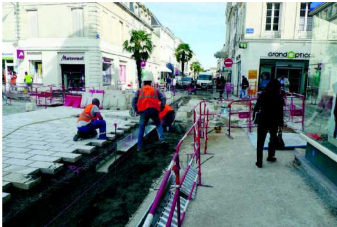
Les trottoirs de la rue Cochon-Duvivier seront élargis. PHOTO D. B.
